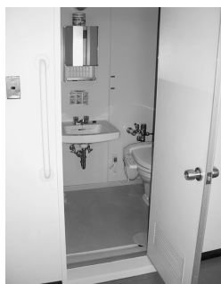
①病室洗面所の改修 (H17～H18)
