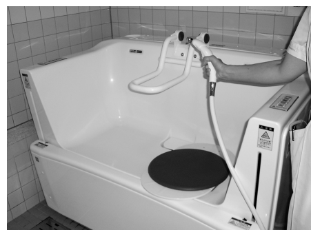
②西・南3階浴室の新しい介護浴槽 (H19・10)
